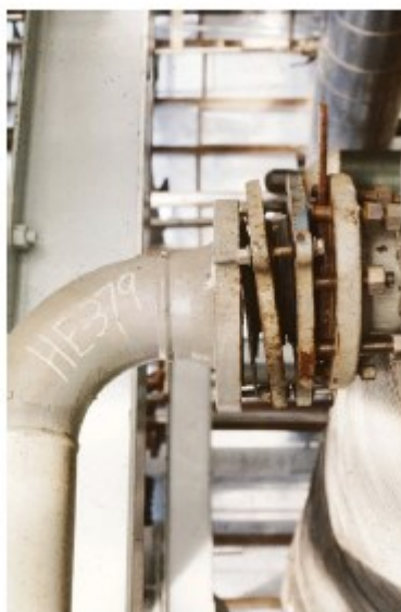
شکل ۱۲-۴- ناهم ترازى لوله (به لطف تيم قابليت اطمینان)
