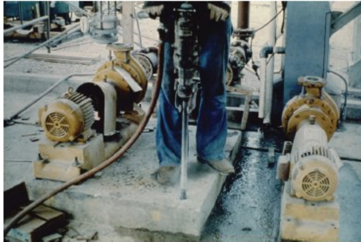
شکل ۱۲-۱ استفاده از مته چکشی روی پایه پمپ جدید (به لطف تیم قابلیت اطمینان)
