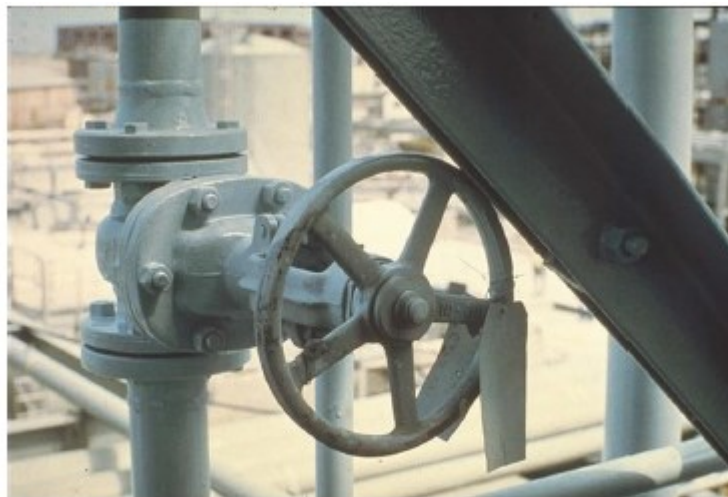
شکل ۱۲-۲ نقطه پیچش ایجاد شده توسط چیدمان تجهیزات (به لطف تیم قابلیت اطمینان)
